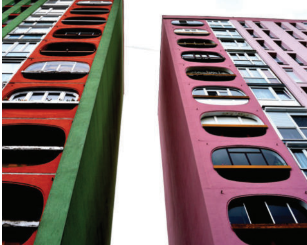
Korszerűsített panelépületek (Komlós Attila fotója)
