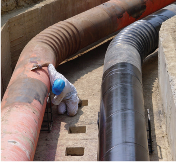
Nagy átmérőjű vezetékszakasz szerelése
