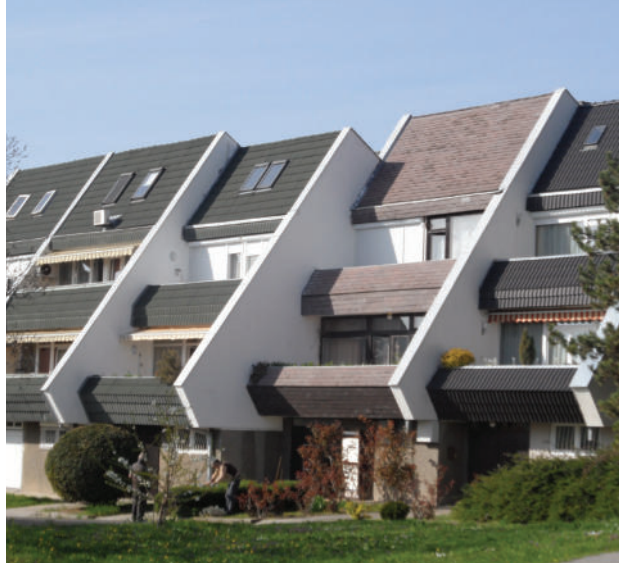
Távfűtés panorámával – lakóházak a Mecsekoldalban
