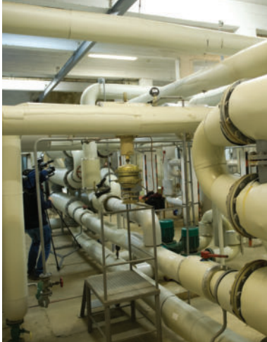
Ez volt – ez lett: lebontásra váró régi tömbhőközpont és korszerű, épületenkénti hőközpont
